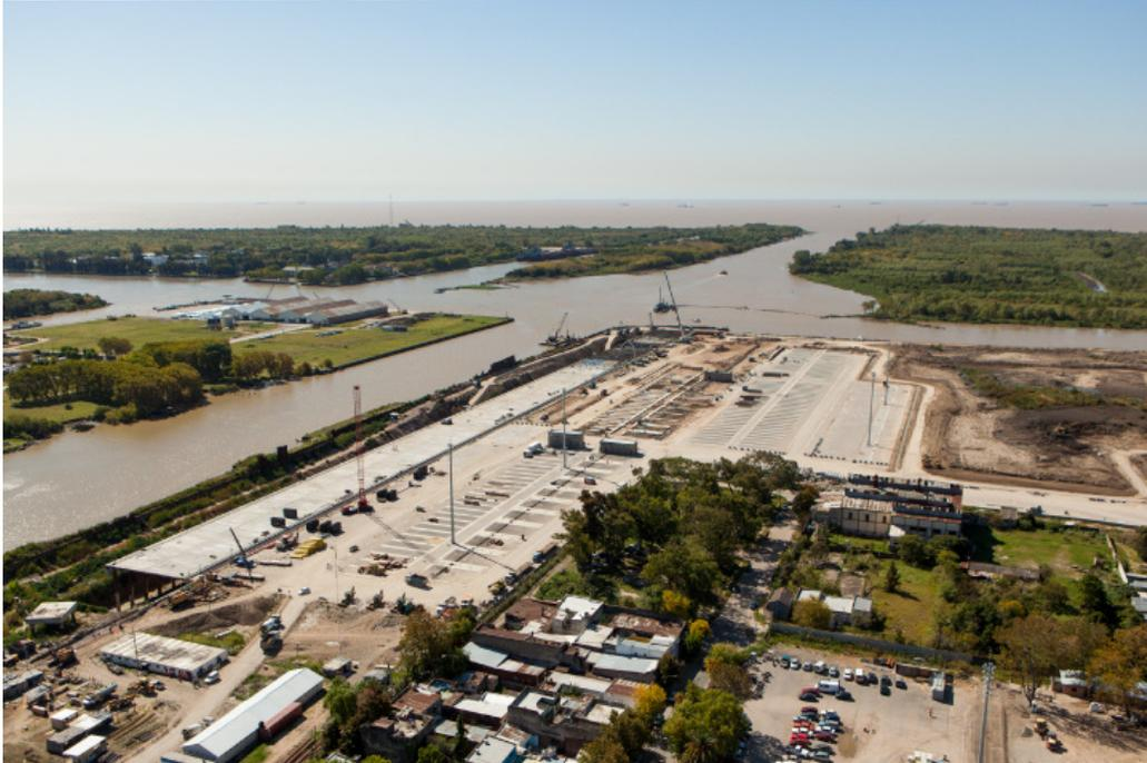
La obra del muelle principal se hizo en seco: se tableestacó el antiguo muelle, y el nuevo se construyó retirado unos 50m de la línea original. Una vez completada la nueva obra, se inundó el espacio adyacente y retiraron las antiguas estructuras, ganándose 50m adicionales de espejo de agua para un mejor giro de los buques. Esto
